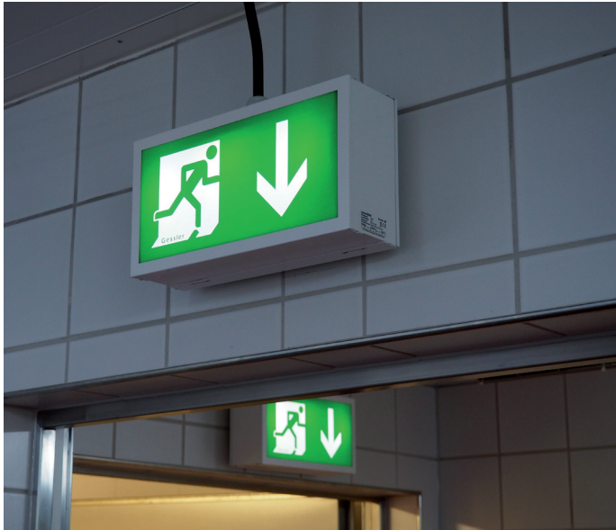
Abb. 6: Beleuchtete Kennzeichnung im Fluchtwegbereich
