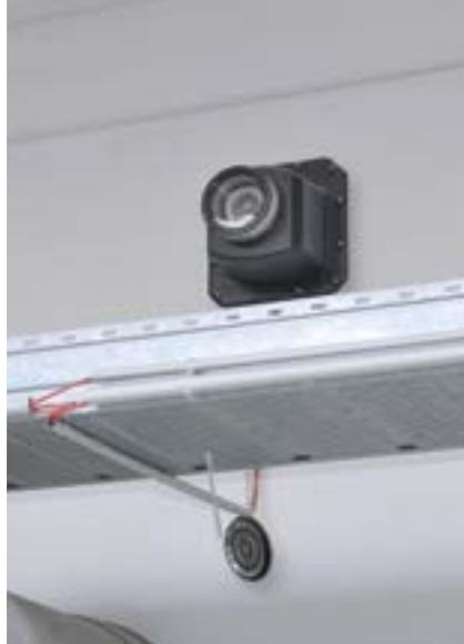
Die 13 in der Halle befindlichen Hekatron Ilia Dust Pro S/E-Melder sind auf die höchste Empfindlichkeitsstufe parametrierbar und lösen dennoch keine Fehlalarme aus.
