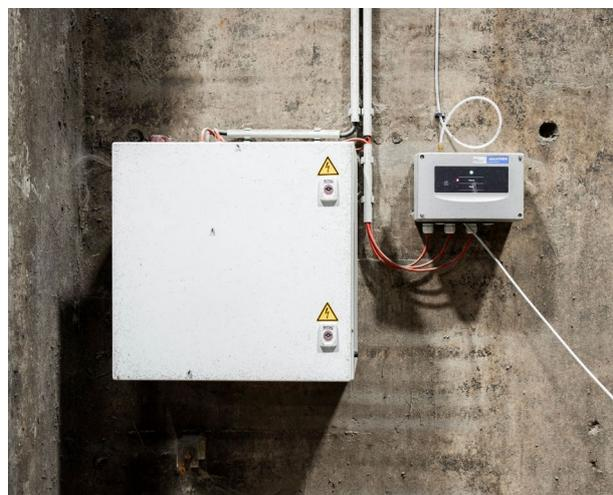
Für extreme Bedingungen konstruiert, der VdS-erkannte Wärmemelder ADW 535 (rechts im Bild).
